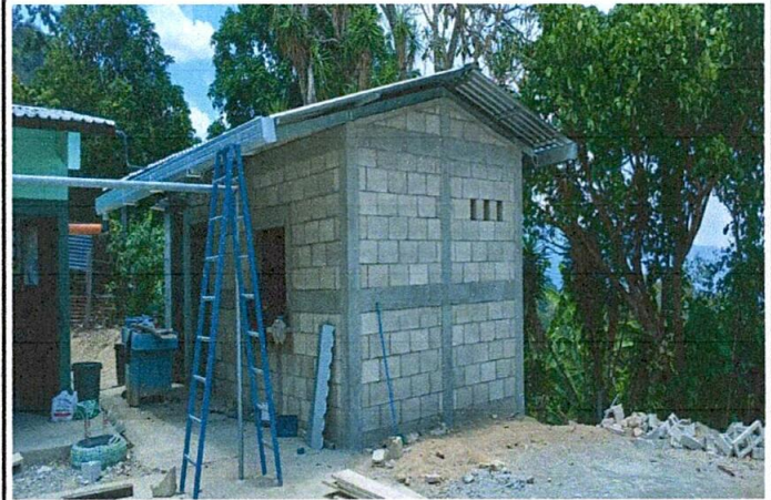
Foto 2: CUBIERTA DE LÁMINA Y REPARACIÓN DE SISTEMA ELECTRICO
